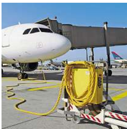
KOSTENFAKTOR STROM: JAL verzichtet nach der Landung auf den Einsatz der Bordgeneratoren und bezieht den Strom vom Flughafen. Das spart Millionen.
